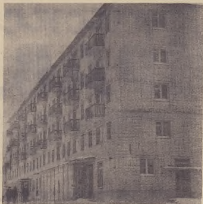
Строители отдела капитального строительства судостроительного завода «Ока» преподнесли хороший подарок корабелам. Недавно они сдали в эксплуатацию новый пятиэтажный 64-квартирный жи-
