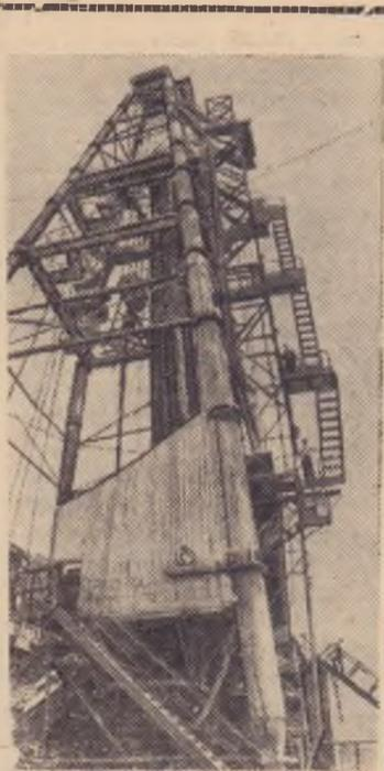
Необычной конструкции буровая высится над узкой Шаховой косой на Апшеронском полуострове. На 70 метров поднимается вышка над землей, скважина уходит вглубь уже на 5 километров.
