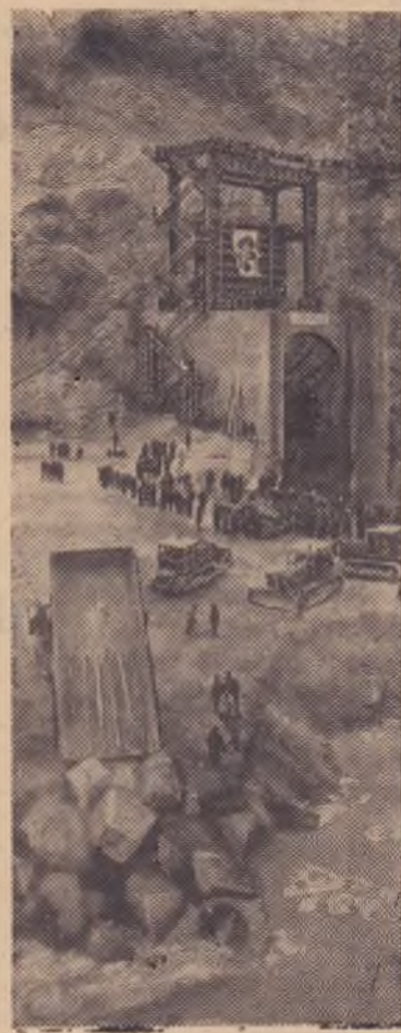
Киргизская ССР. Строители Токтогульской ГЭС направили бурный поток Нарына по новому руслу. Оно пробито сквозь толщу скального монолита. Подземный коридор высотой в пя-
