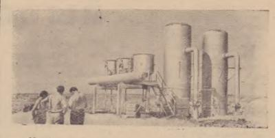
Необычная «кладовая» построена вблизи Ташкента-Полторацкая опытная станция подземного хранения газа. Хранилище расположено на глубине 600-700 метров и способно вместить свыше миллиарда кубометров природного газа. Этого количества топлива достаточно для покрытия сезонных и суточных колебаний его потребления в трех крупных индустриальных центрах — Ташкенте, Чирчике и Чимкенте.
