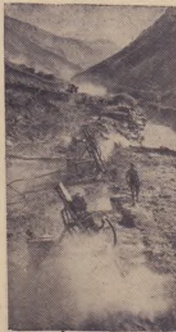
ТАДЖИКСКАЯ ССР. На строительстве Нурекской ГЭС. Самоходные бурильные установки на правом берегу Вахша. В нынешнем завершающем году семилетки начнется открытие реки.
