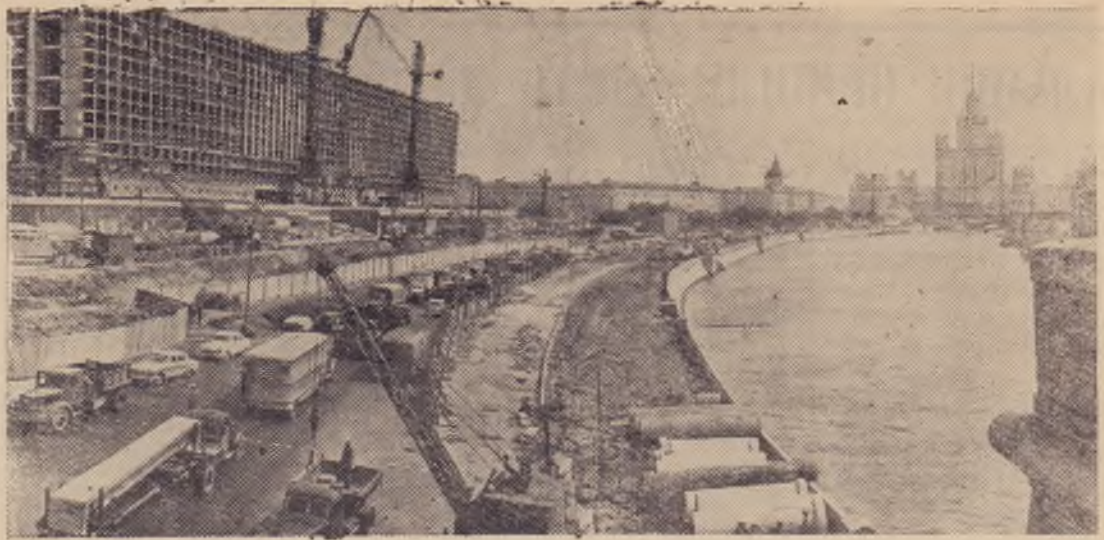
Москва. Москворецкая набережная. Непрерывным потоком идут по ней машины со строительными грузами и изделиями промышленности. Слева—строительство гостиницы «Россия». Фото В. Кунова.
